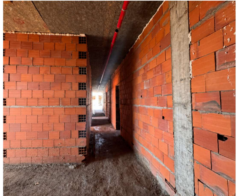
Instalaciones eléctricas en N3 – Elevación de mamposterías en N5
