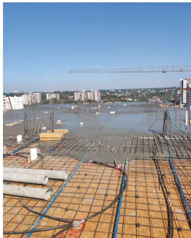
Cargamento de pilares N9-N10 - Cargamento Losa N9
