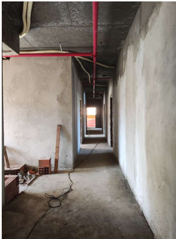
Revoque en departamentos N2 – Revoque en pasillos - Cargamento RDC N1
