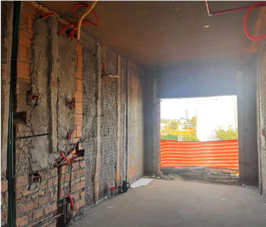
Instalaciones eléctricas en N3 – Elevación de mamposterías en N5
